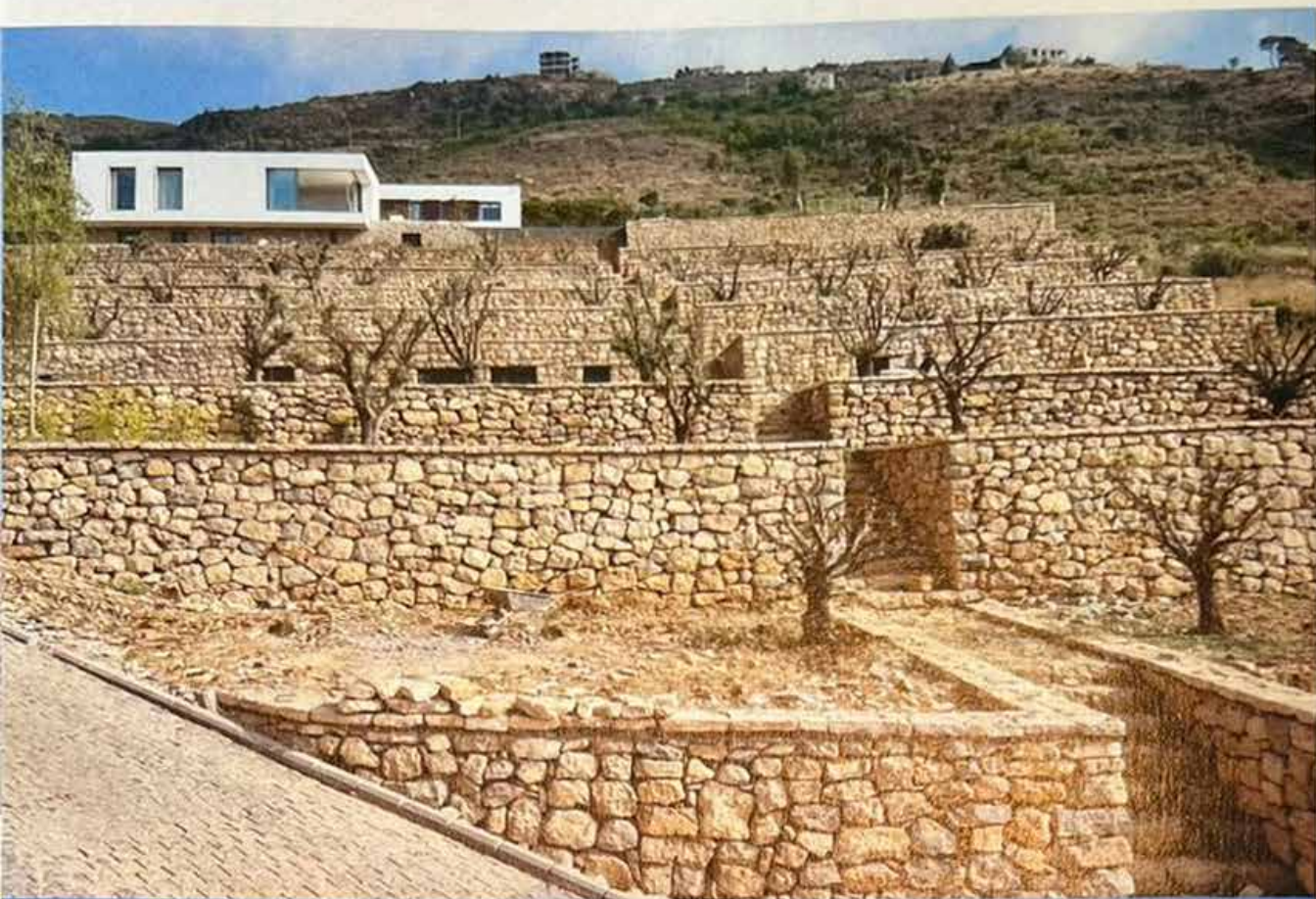
Il. 178. Perspektywa w kierunku południowym. Willa w Brih, projekt Elie Abs 2016. Fot. Elie Abs 2016
